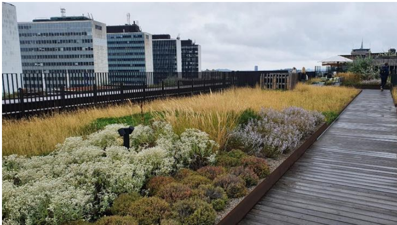
Figur 27 Exempelbild av ett grönt tak, Sweco.
